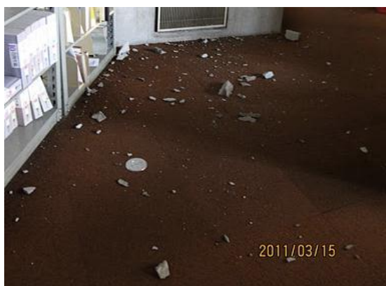
【壁・天井の破損(コンクリート塊の落下)】
