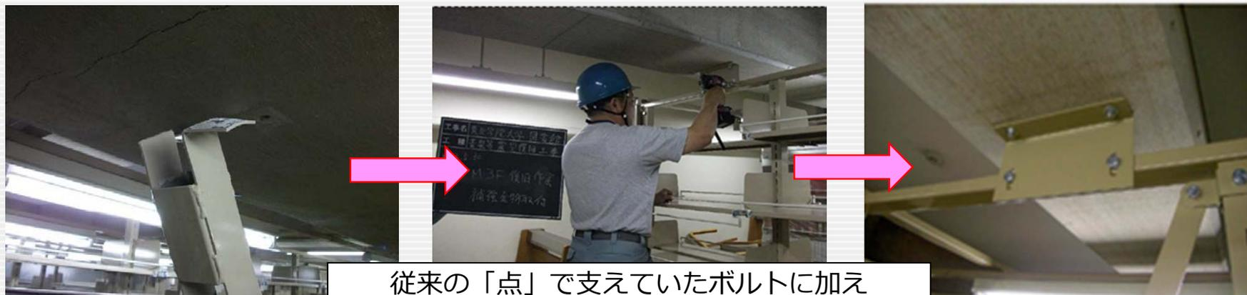
従来の「点」で支えていたボルトに加え「面」で支えるボルトを追加
