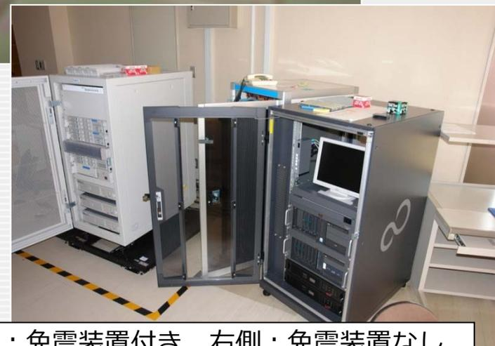
左側：免震装置付き 右側：免震装置なし
