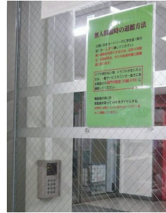
入退館システム カードリーダーに身分証を通すと、 ロックが解除されドアが開く
