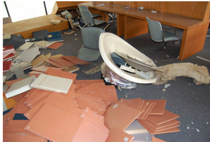
落下した通風孔で、机や資料が破損しています。
