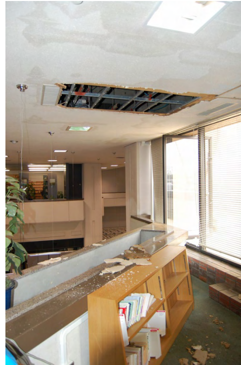
2階:天井が落ちてしまいました。(3月14日撮影)
