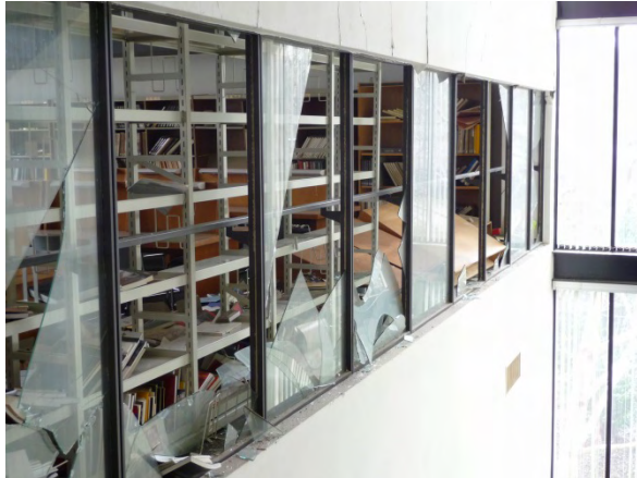
3階の吹き抜け：窓ガラスが破損しています。地震の衝撃が判ります。
