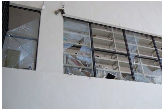
3階の吹き抜け：窓ガラスが今にも落ちそうです。また壁に亀裂が見えます。
