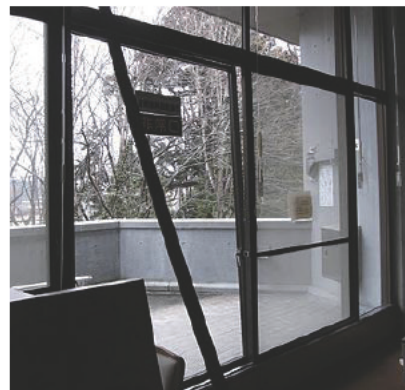
【窓枠の歪み(開閉不能)】
