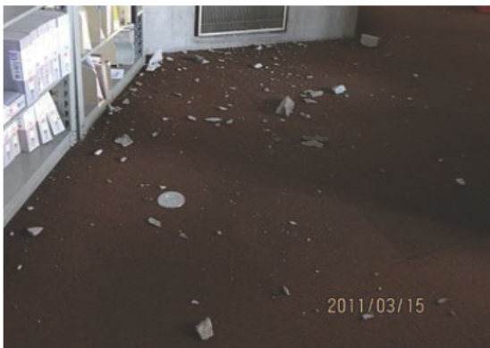
【壁・天井の破損(コンクリート塊の落下)】
