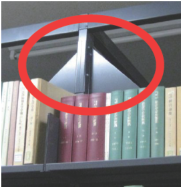
【補強金具の取付】
