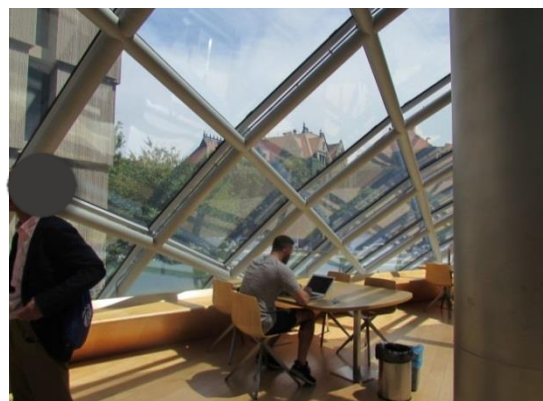
[1枚のガラスパネルの大きさは約2x2m、平面状のものを曲線の枠にはめ込んだ。春先、積もった雪が解けて滑り落ちる時には大音響が]
