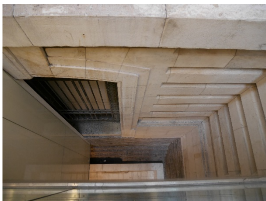
図 5 現存する 1911 年の壁（最下部）
