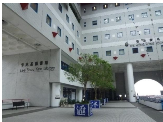
図書館の入口はアトリウムに面している
