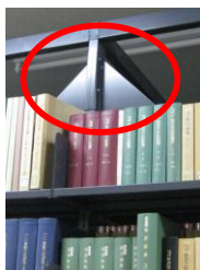
補強金具の取付
